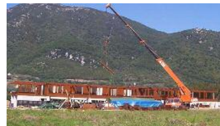
2004 г . Дом с системой домашней автоматизации
